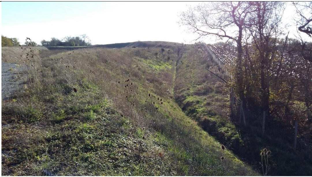
Digue et fossé Sud (vue vers l'Est – nov.2018)
