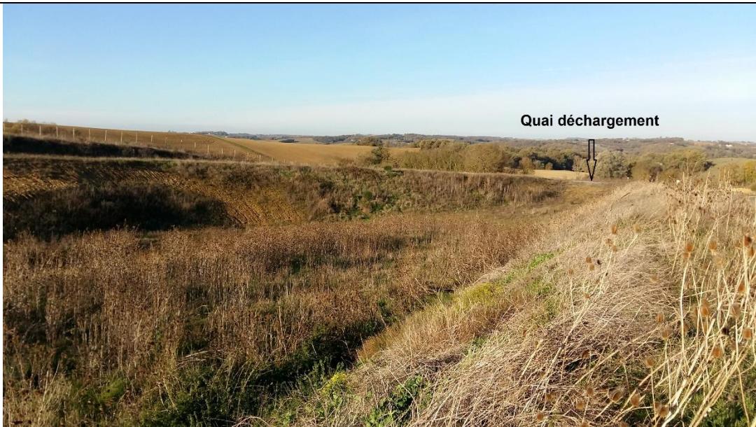
Vue de la partie Ouest du casier ISDI (nov. 2018)
