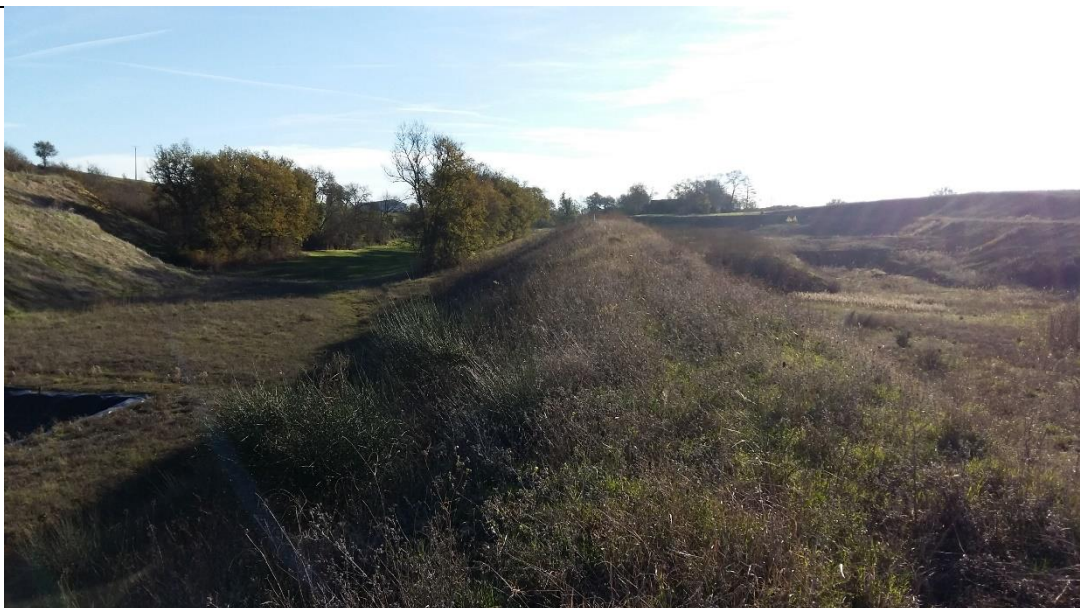
Digue nord du casier ISDI (vue vers l'Est - nov. 2018)
