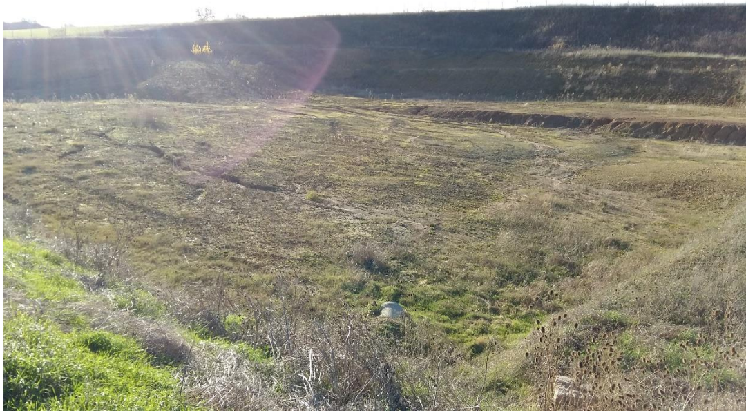
Vue de la partie Est du casier ISDI (nov. 2018)
