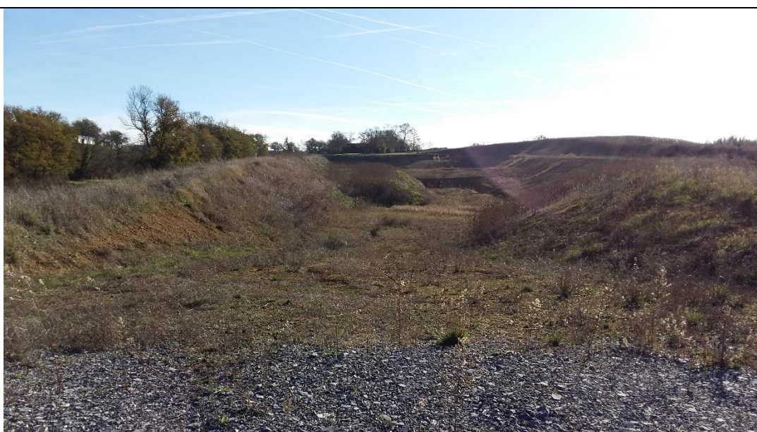
Vue du casier ISDI depuis le quai (vue vers l'ouest – nov.2018)
