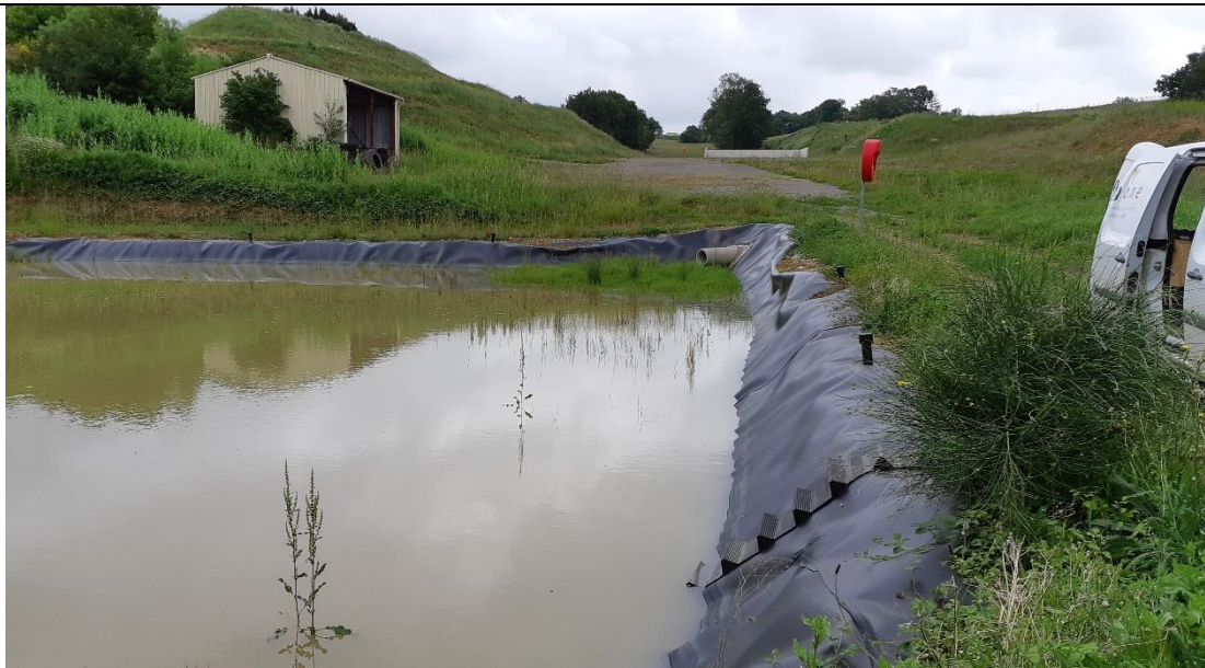
Bassin pluvial (vue vers l'Est – mai 2018)
