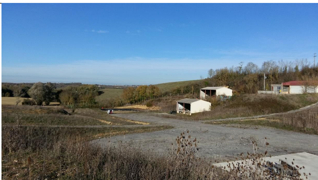
Vue vers l'est depuis le quai (avant travaux de réfection de la voirie – nov.2018)
